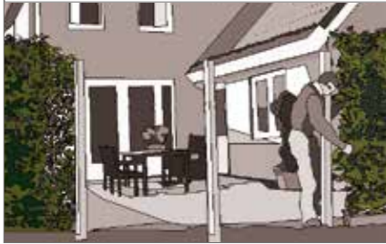
9.35h Plantación de paneles y fijación a los postes
